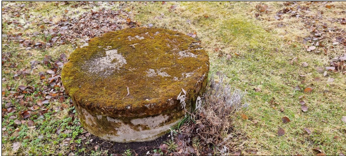
Kuva 1. Kaivo 31, korko mitattu betonikannen päältä (2.5.2023 / Mitta Oy)
