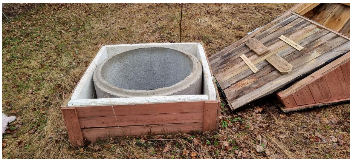
Kuva 2. Kaivo 27 (2.5.2023 / Mitta Oy)
