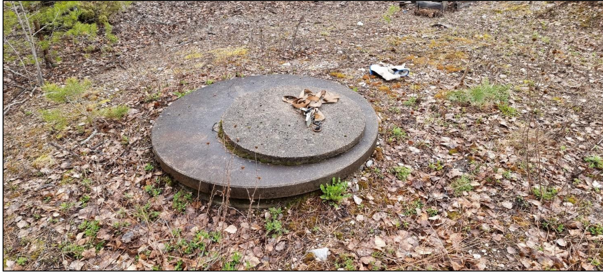
Kuva 1. Porakaivo 31p (2.5.2023 / Mitta Oy)
