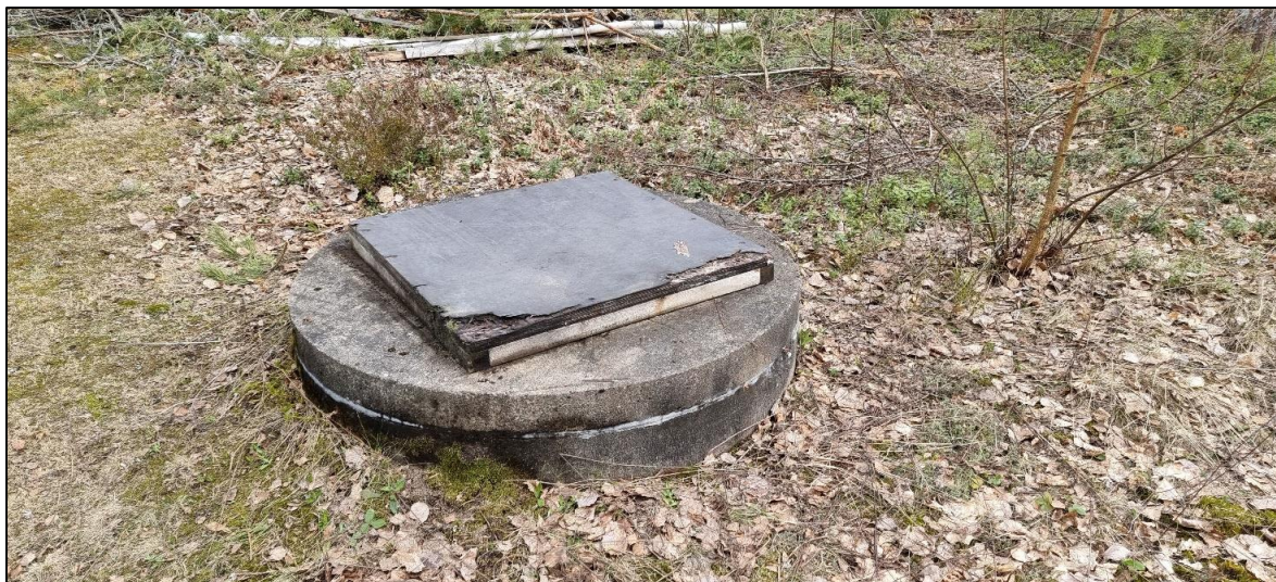
Kuva 1. Kaivo 30 (2.5.2023 / Mitta Oy)
