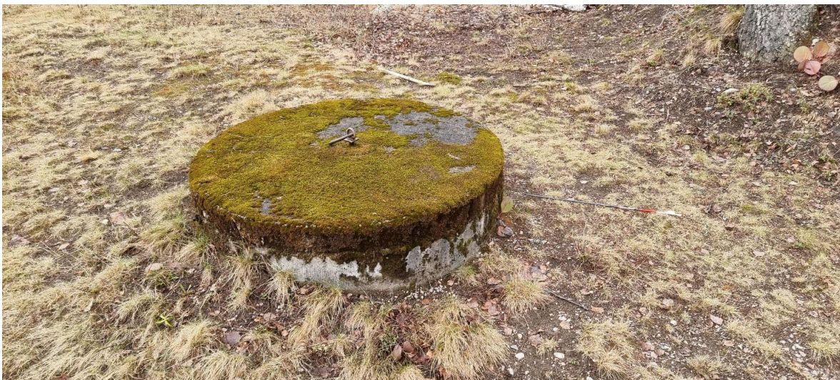
Kuva 2. Kaivo 31b, 6787013.947, 28507274.106 (ETRS-GK28) kannen korko +81,367 (N2000), maanpinnan korko + 81,168 (N2000). Kaivoa käytetään vain sadevesien keräykseen. (2.5.2023 / Mitta Oy)
