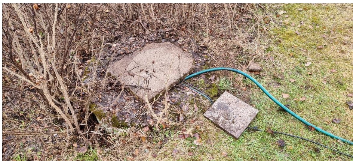
Kuva 1. Kaivo 28 (2.5.2023 / Mitta Oy)
