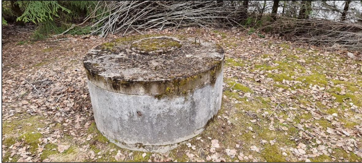
Kuva 1. Kaivo 29 (2.5.2023 / Mitta Oy)
