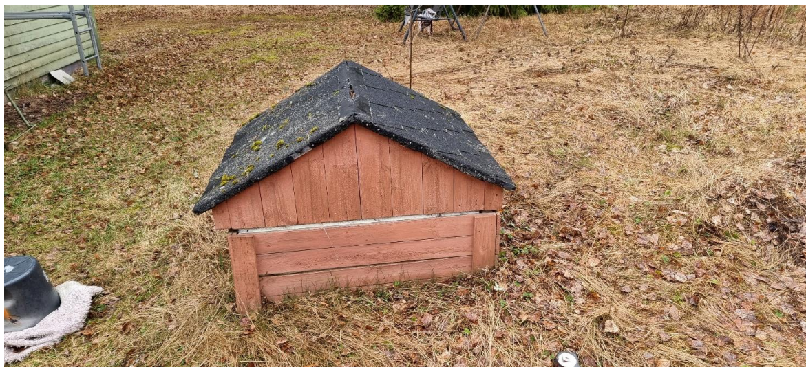
Kuva 1. Kaivo 27 (2.5.2023 / Mitta Oy)
