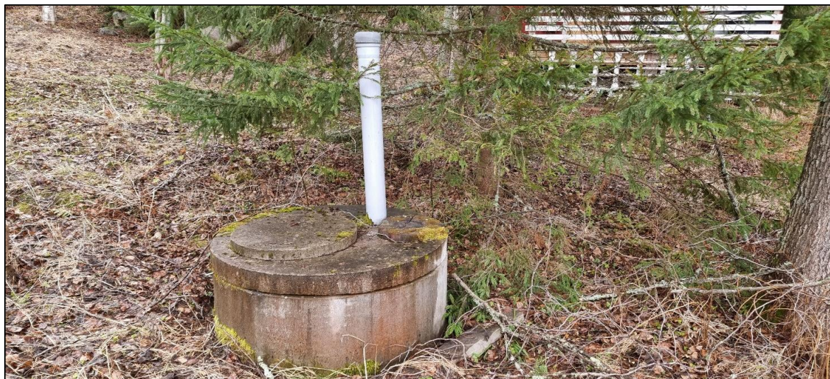
Kuva 1. Kaivo 32 (2.5.2023 / Mitta Oy)
