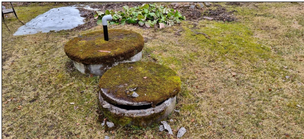
Kuva 1. Takana on kaivo 25a ja edessä kaivo 25b. (2.5.2023 / Mitta Oy)
